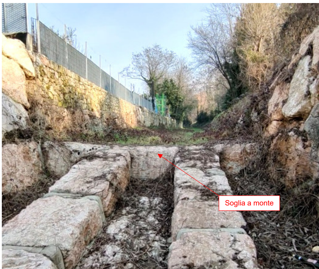
Foto 6: Vista verso monte della soglia a nord del sito di intervento
