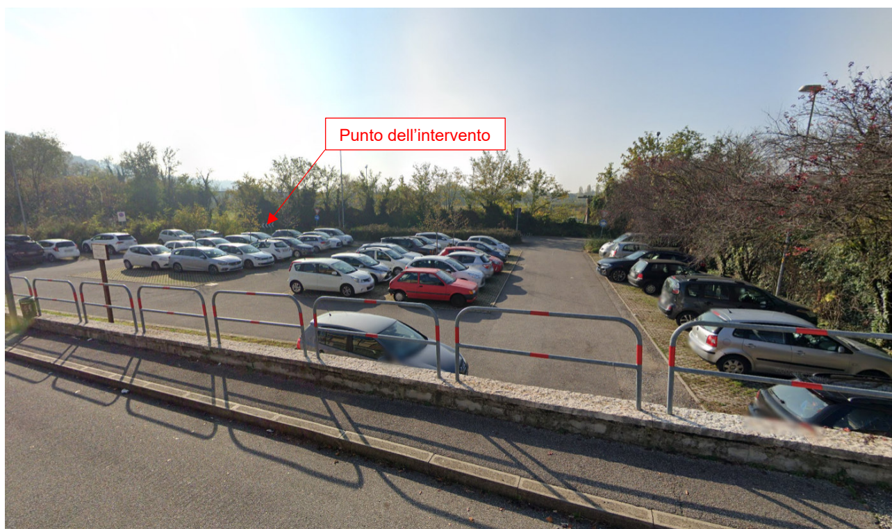
Foto 1: Vista sul parcheggio di via della Consortia
