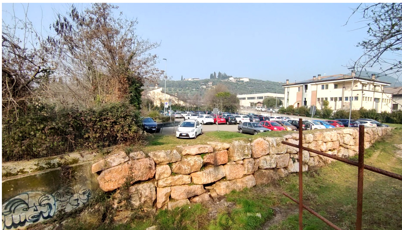
Foto 4: Vista del parcheggio dall'argine sinistro
